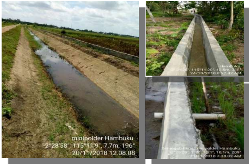
Gambar 5 Longstorage yang berfungsi sebagai saluran irigasi /drainase utama dan saluran irigasi tersier
