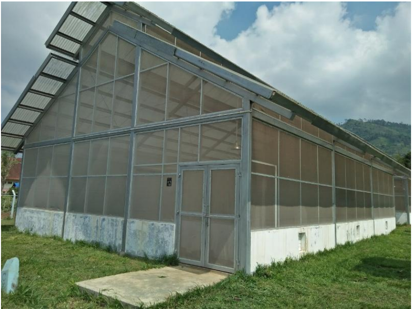
Gambar 4. Tipe piggyback greenhouse cocok untuk daerah tropis Sumber: Pustaka, 2019
