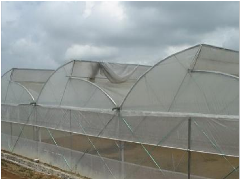
Gambar 5. Tipe multispan cocok untuk kegiatan greenhouse yang luas Sumber: ediskoe.blogspot.com, 2025
