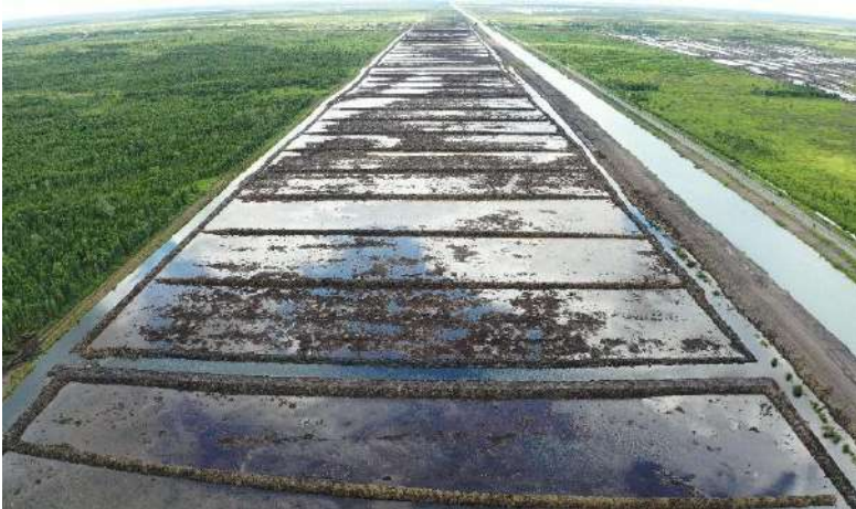
Gambar 2. Cetak sawah di Provinsi Kalimantan Tengah
