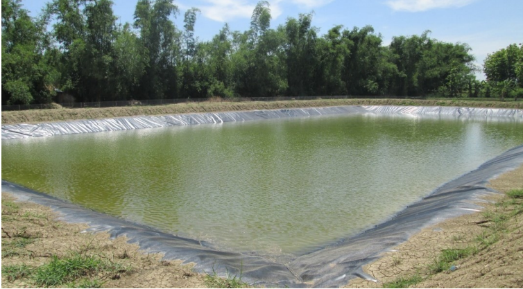
Gambar 4. Embung berlapis geomembran di lahan Food Estate Hortikultura 200 ha di Kabupaten Humbang Hasundutan, Provinsi Sumatra Utara.
