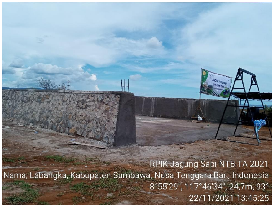
Gambar 3. Proses pembangunan bunker silase di KTM Labangka telah selesai pada 22 November 2021
