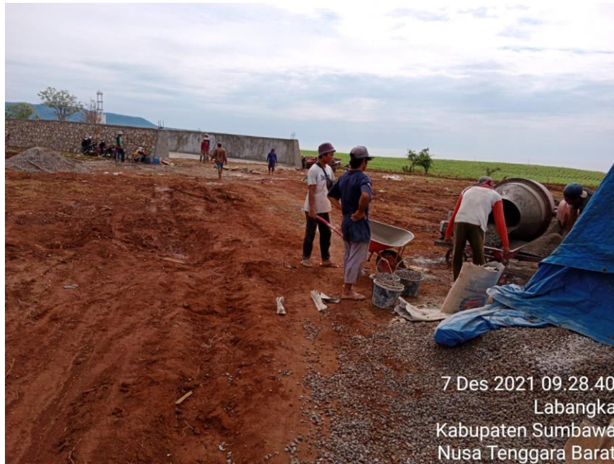
Gambar 7. Proses pengerjaan penguatan lantai bunker silase di KTM Labangka
