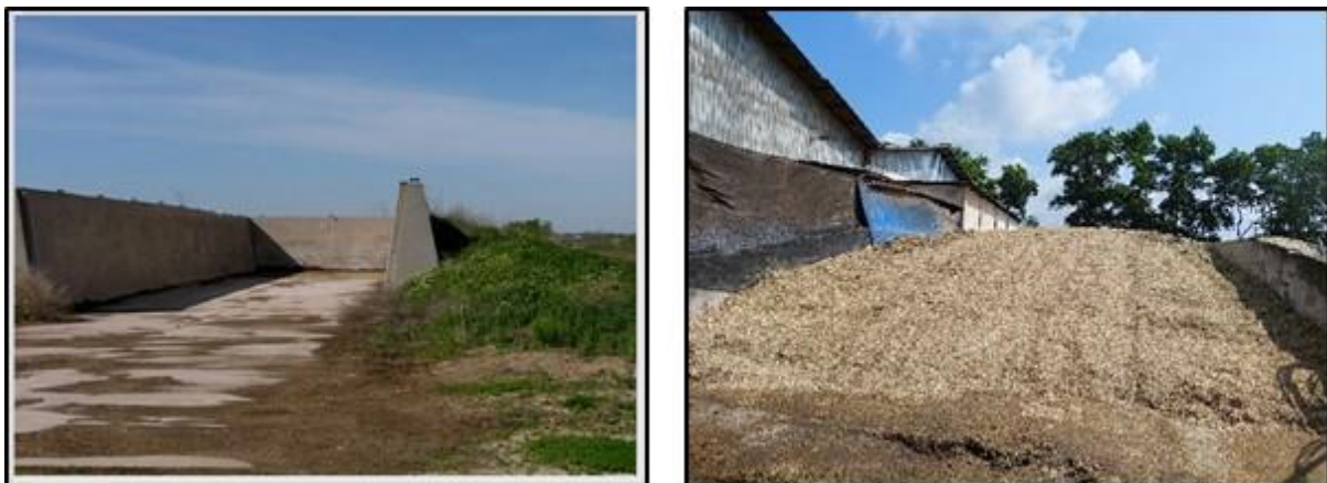
Gambar 16. Silo/Bunker kapasitas 500 ton/bunker
