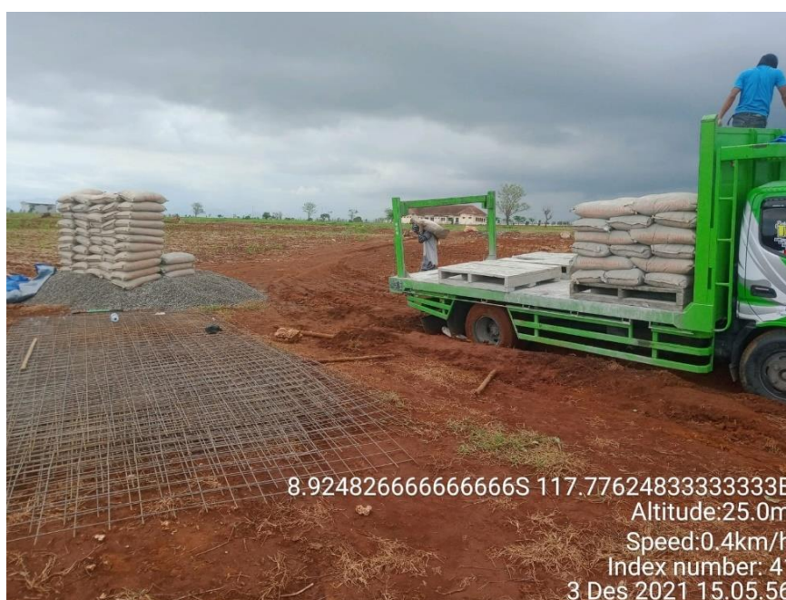
Gambar 6. Pengadaan barang untuk penguatan lantai bunker silase di KTM Labangka
