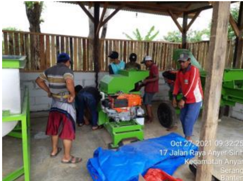
Gambar 23. Pemasangan dan setting mesin penggiling ( hammer mill )
