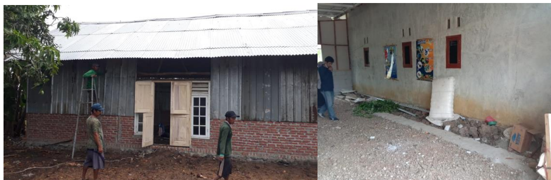
Gambar 20. Proses pembangunan bangunan pabrik pakan
