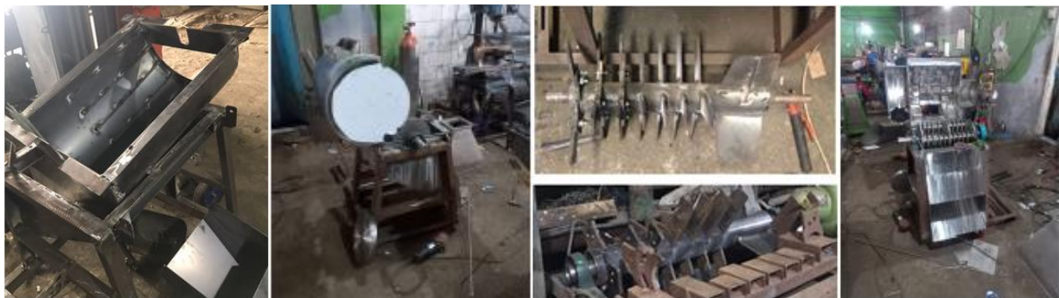
Gambar 22. Proses pabrikasi mesin penghancur tipe hammer mill
