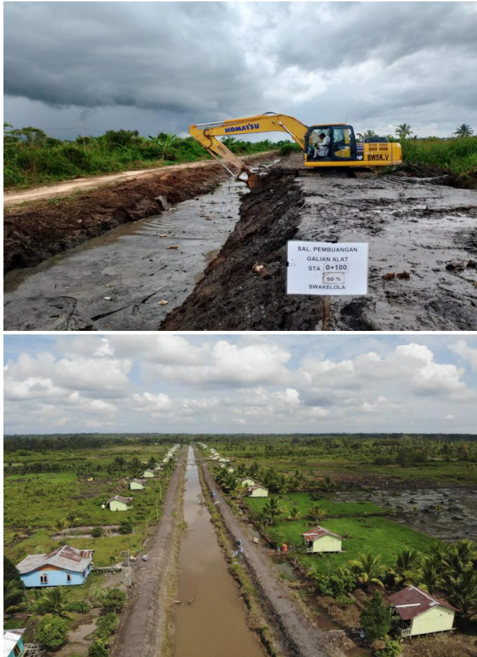
Gambar 9. Rehabilitasi infrastruktur irigasi yang dilakukan oleh Balai Besar Wilayah Sungai Kalimantan Utara di DIR Sajau dan SP 10, Kabupaten Bulungan
