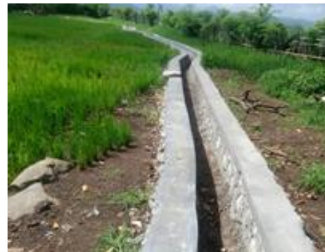
Gambar 1. Pendistribusian air pada lahan pertanian melalui saluran terbuka
