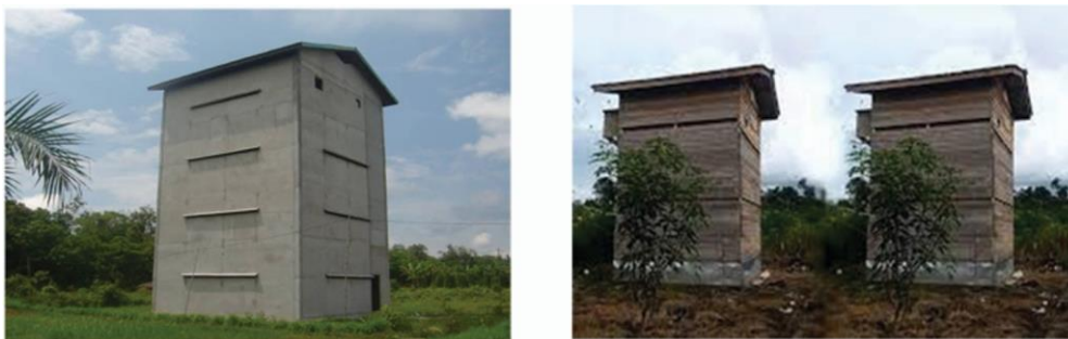
Gambar 2. Contoh Rumah Sarang Burung Walet di Cilegon (kiri) dan Pandeglang (kanan) Sumber: Hasil Pengamatan di Pandeglang dan Banten, 2024
