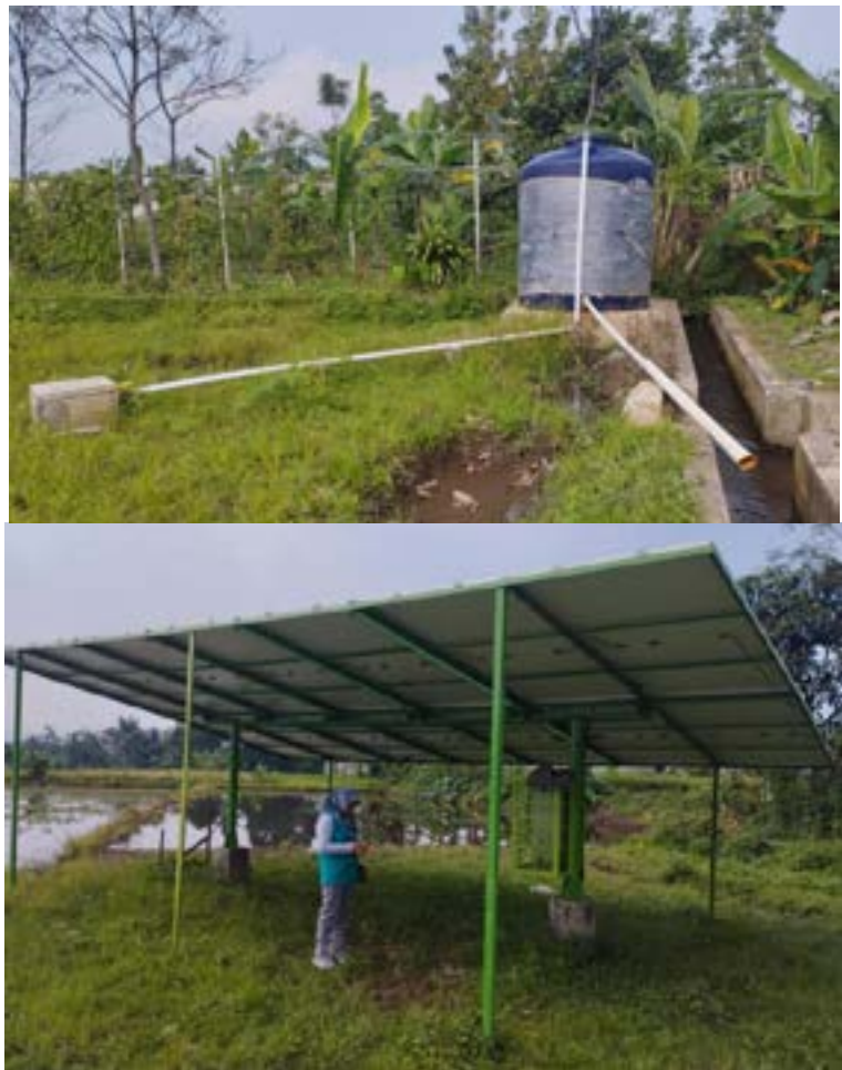
Gambar 3. Penerapan tenaga surya untuk pompanisasi di lingkungan IP2TP Kebun Muara Sumber: Eni (2025)
