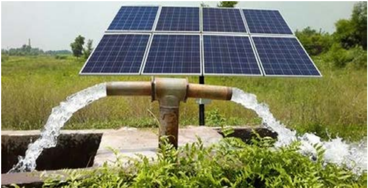
Gambar 2. Pompanisasi air dengan tenaga surya. Sumber : Surya Utama Putra, tahun 2024
